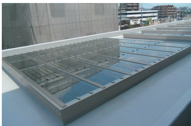
▲RC1-GA 片流れ・ピースガラス押え・外部側塗装仕様
