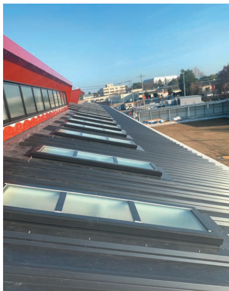
▲RC2-GA:外部側塗装仕様 外観
