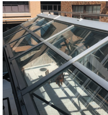
▲RC1-GA 両流れ・ファスナー式 棟部メンテナンスパイプ付
