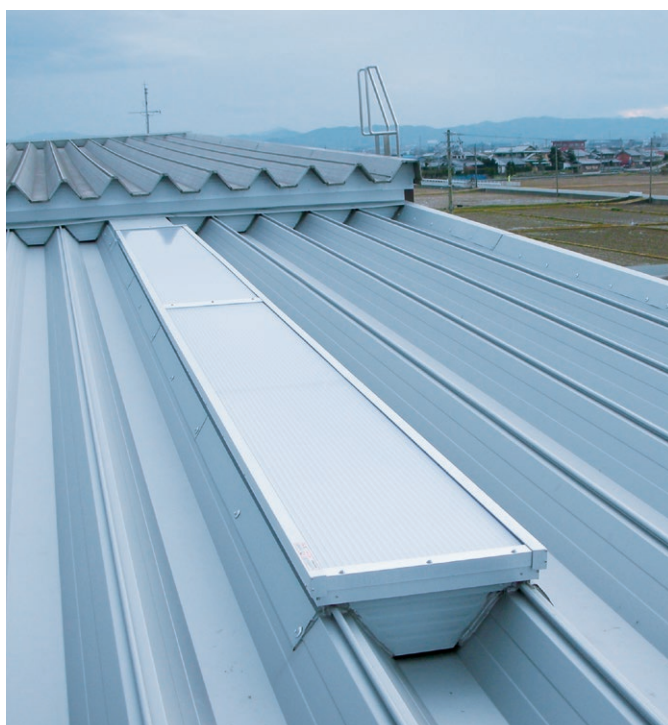
ミツイバウマテリアル倉庫増築工事(外観)
