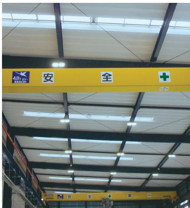
ミツイバウマテリアル倉庫増築工事(内観)
