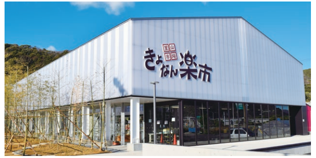
都市交流施設・道の駅 保田小学校 場所:千葉県安房郡鋸南町 設計:NASCA設計共同体 製品:ルメウォールW650,W770
