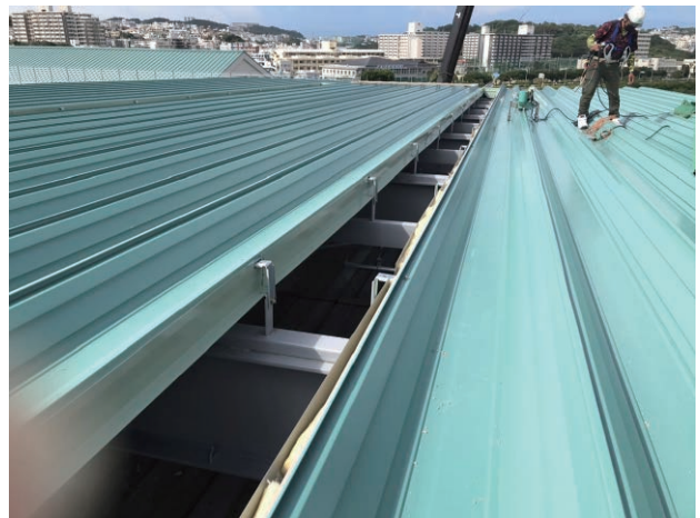
▲断熱屋根用 ワイド500 単板+中空シート(クリア)仕様 ※妻タイトピッチ調整施工
