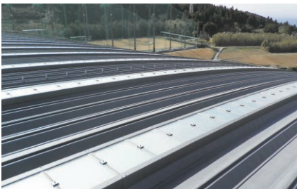
▲断熱屋根用 ワイド500 単板ガラス+中空シート(乳白)仕様 ※妻タイトピッチ調整施工
