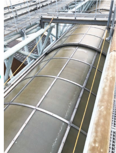
改修後 MAMORI・21 N 塗装完了 乾燥後は透明に変化
