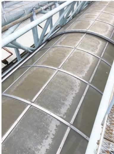
改修前 トップライト外観
